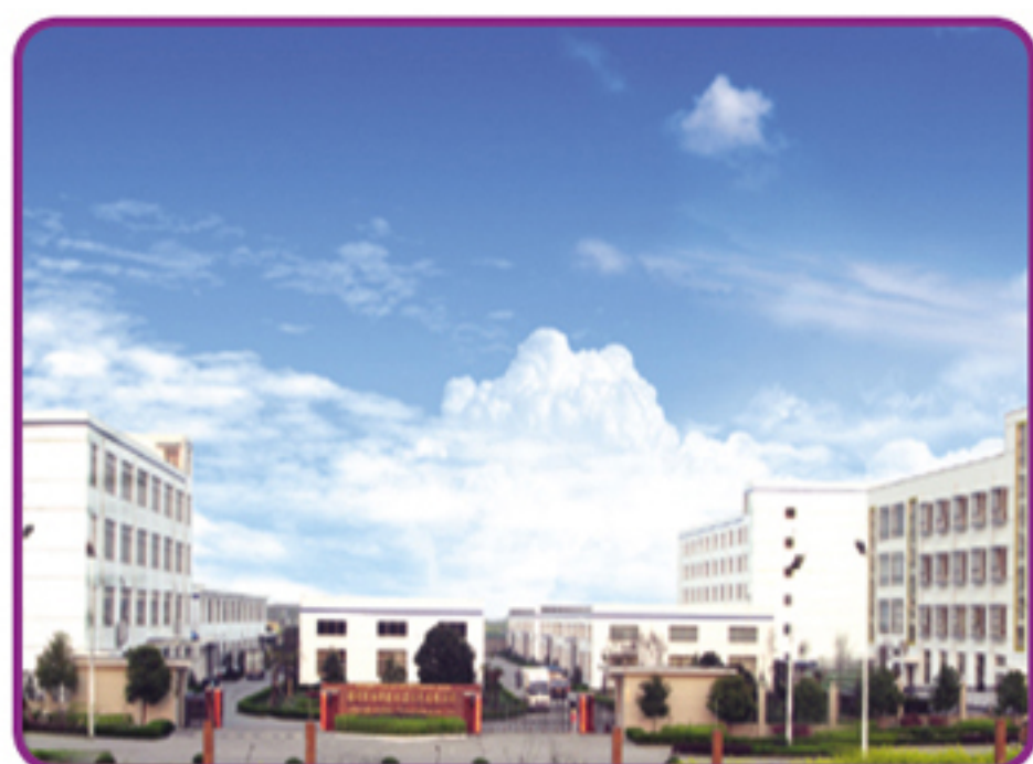
1- 百仕德工厂 Bestpak factory
